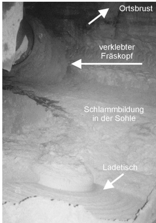
Bild 7 Situation vor dem Ladetisch: Die Ladescheiben der TSM sind nicht in der Lage, den Erdbrei in den Förderkanal zu transportieren. Im Hintergrund: Stark zugesetzter Längsschneidkopf (4).
